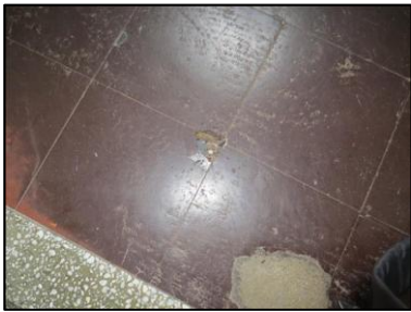
Photo N° 1088 REVETEMENT DE SOL --PALIERS +1 à +4 Planchers Dalles de sol
