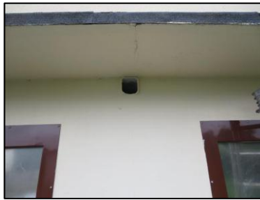
Photo N° 1089 AMIANTE CIMENT - -LOCAL POUBELLES RDC Murs Ventilation haute (Fibres-ciment)
